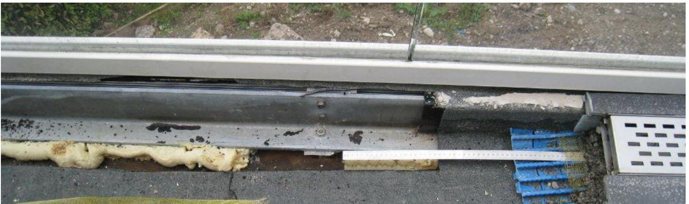
Abb. 5 - Ganzglasgeländer „Integral“ : nicht sanierungsfähig
